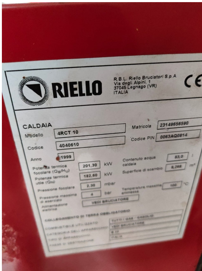
Fig. 6 – Caldaia RIELLO 4RCT 10N
